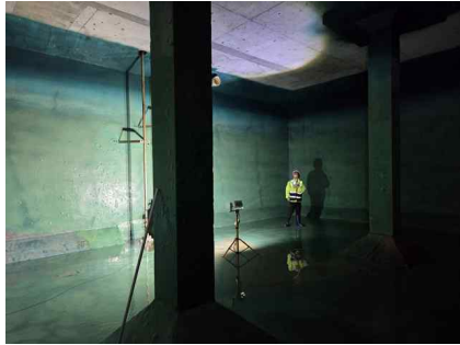
<내부 개별부재 외관조사>
