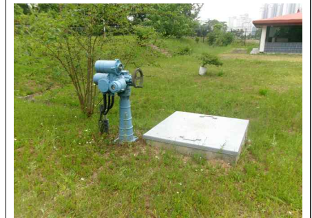
<환기구 등의 덮개(장비 반입구) 현황>
