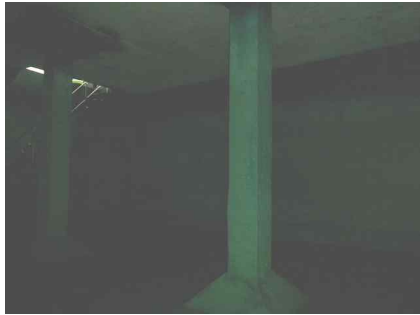
<배수지 1지 전경>
