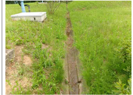
<부대시설 배수로 전경>
