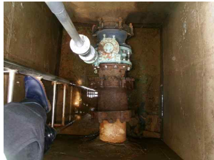
<유입밸브실(1지) 바닥슬래브 채수>
