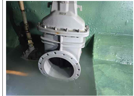
<2지 유출배관 상태양호>
