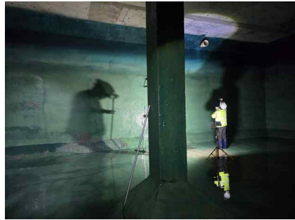
<배수지 2지 전경>
