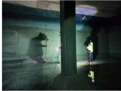
<내부 개별부재 외관조사>
